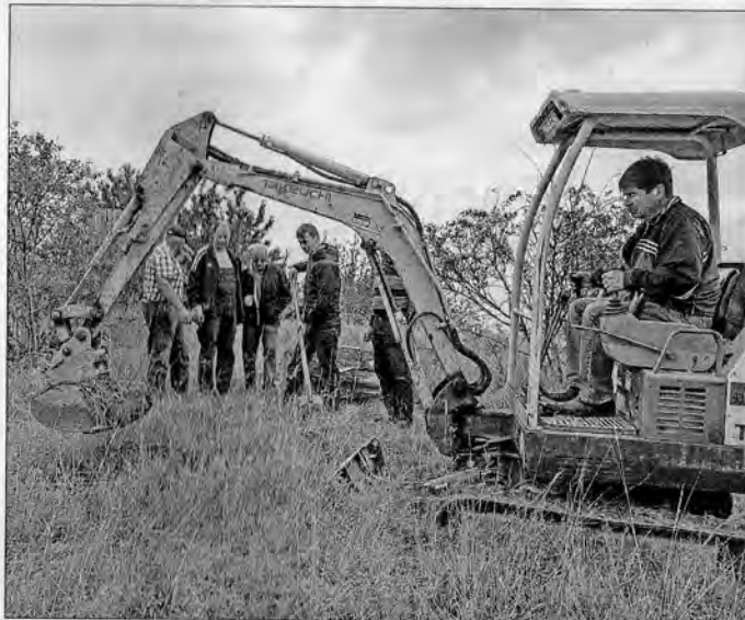
Der Bagger im Einsatz
